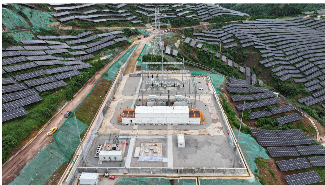
图 2-2 220kV 关累镇藤蔑山升压站现状
