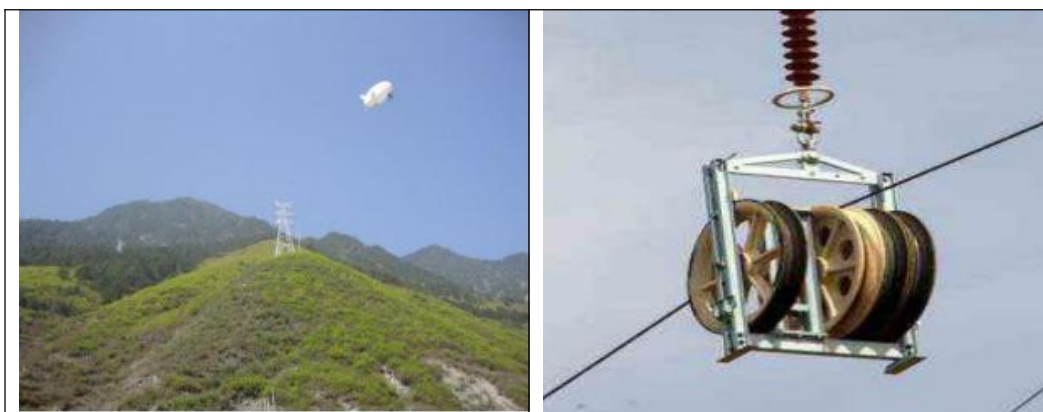
图 2-5 牵引及放线施工图片
