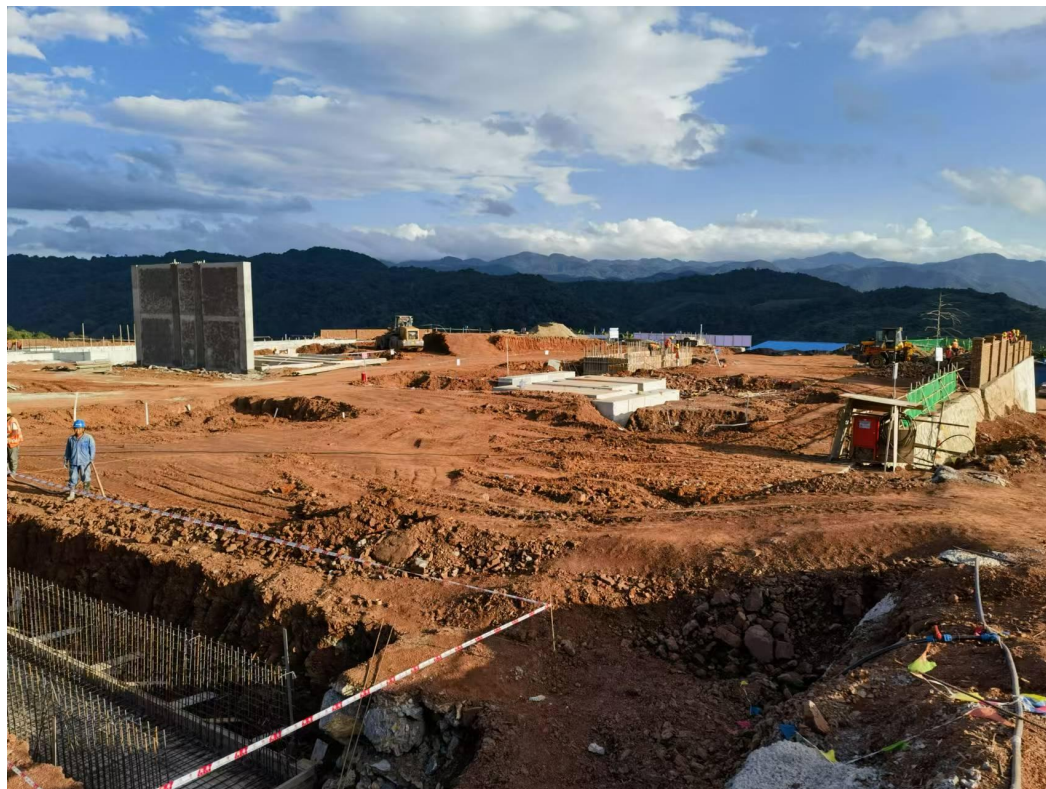
图 2-1 220kV 易武镇乌沙河下寨升压站现状
